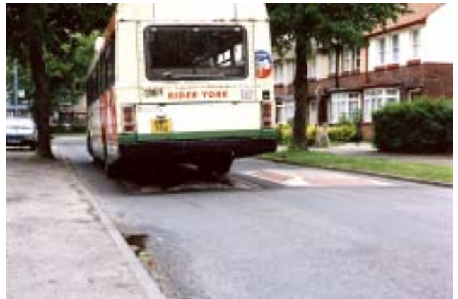
(d) Block paved cushion Tang Hall (site 24) (Picture TRL)
